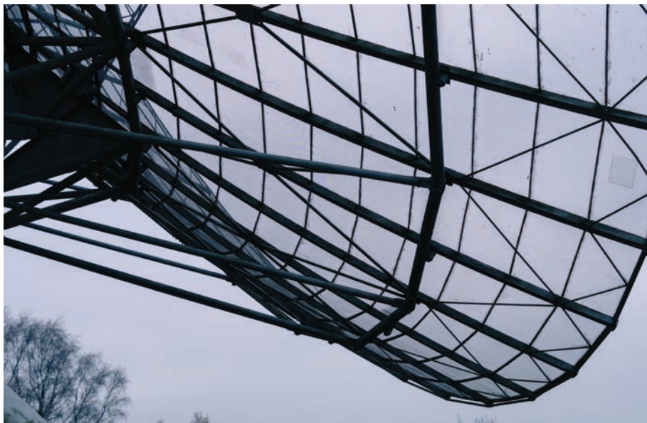
De schotels zelf bestaan uit een fijn gaas dat gespannen is in een metalen frame.
