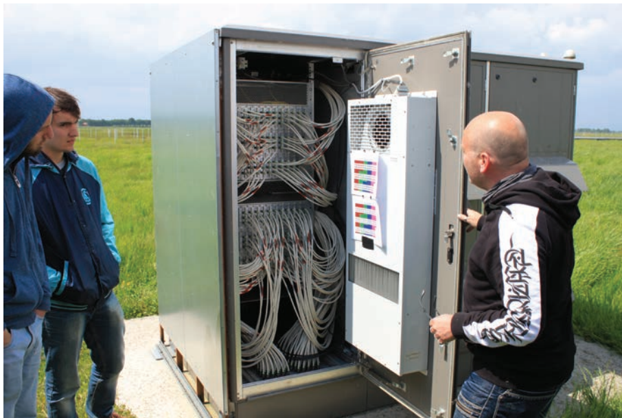
De LOFAR data wordt verzameld in grijze kasten vol draden en een tijdelijk opslaggeheugen.
