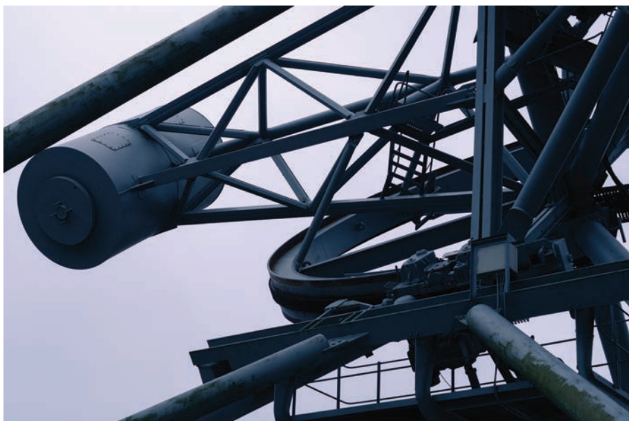
De antennes staan op een equatoriale montering, om te zorgen dat ze niet uit balans raken is aan de andere kant een contragewicht bevestigd.
