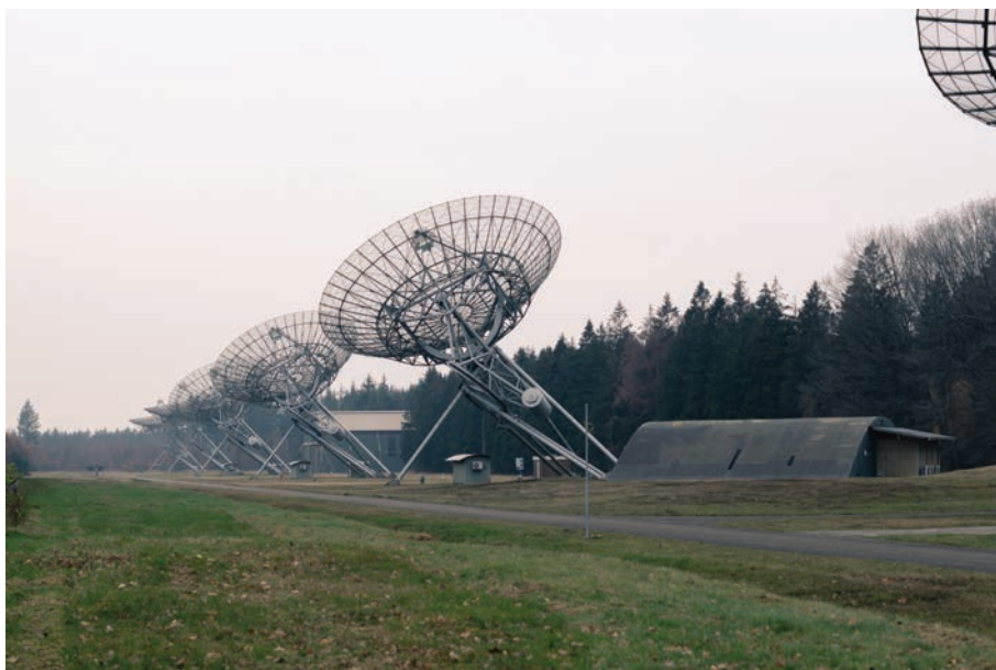
De Westerborktelescoop bestaat uit een lange rij schotelantennes. De laatste paar schotelantennes staan op een rails, zodat ze verschoven kunnen worden. Dit verbetert de precisie van de Westerbork telescoop.
